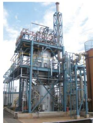
液中燃焼式廃液焼却設備
