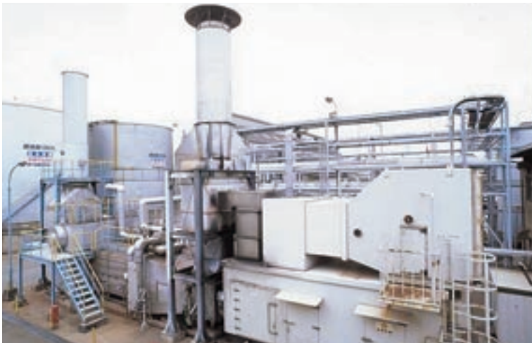
SOx、ばいじん低減にも有効なCO2ジェネレーション設備（別府工場）
